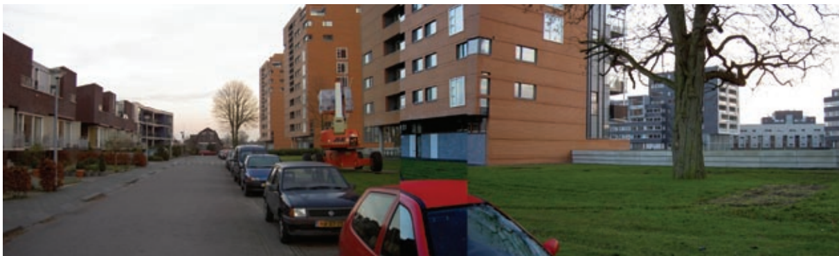
De rij eengezinswoningen kijken tussen de woontorens (scherm/filter) uit over de ruimte van het kanaal. De opstaande rand van de Parkeergarage zoomt de ruimte mooi af; het kanaal ligt achter en niet aan de straat.
