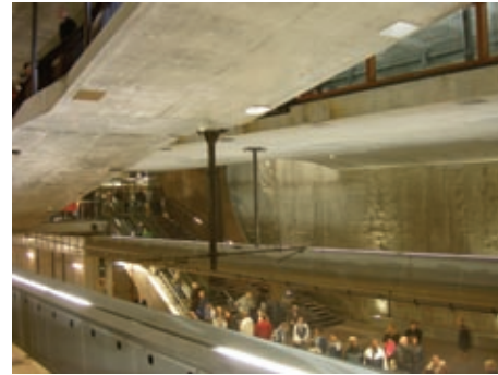
Aandacht voor de ondergrondse wereld: de Haagse tramtunnel is een feestelijke aankomsthal
